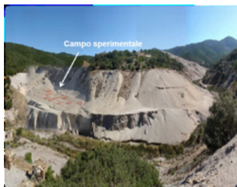
Miniera dismessa di Ingurtosu, Sulcis Sardegna, preparazione del campo sperimentale di fitorisanamento assistito da batteri
